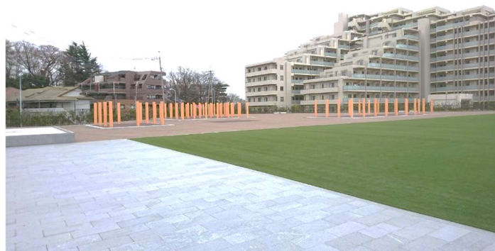
第1期整備部分（北西側から）
